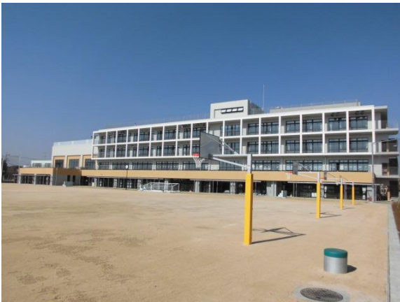
広い校庭から撮影した校舎の外観
