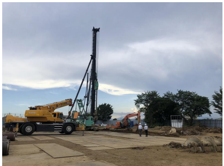
杭工事の様子（令和元年8月撮影）
