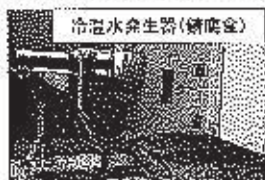
冷温水熱交換器(錆腐食)
