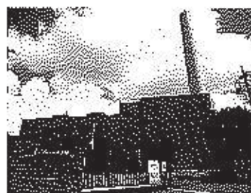
旧清掃工場の外観
