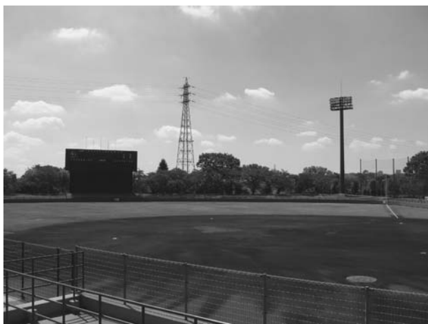
改修した立川公園野球場
