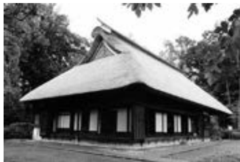
川越道緑地古民家園内「小林家住宅」
