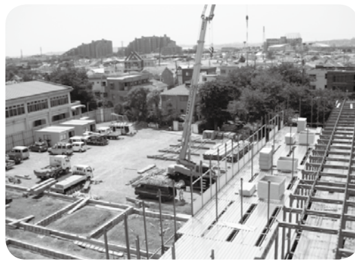
第六小学校の校庭内に建設中の仮設校舎
