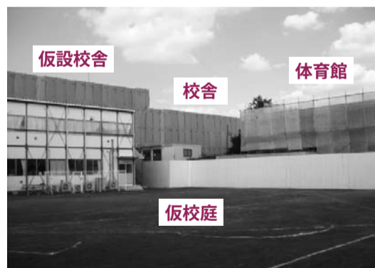
第六小学校の大規模改修工事の様子
