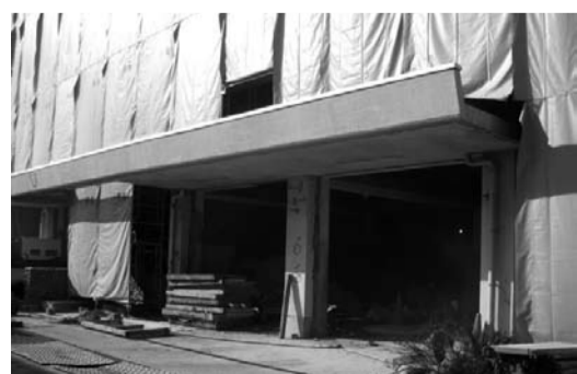
校舎の1階昇降口です。解体工事で内装がはがされ、サッシなども取り外されました。
