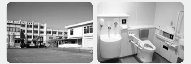
リニューアルした校舎と体育館 新設した多目的トイレ
