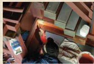
彫桁下の部材にベンガラを塗る職人
