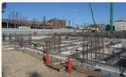
③ 基礎工事 (令和元年11月)
