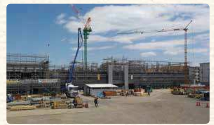
⑤ 校舎棟のコンクリート打設工事 (令和2年4月)
