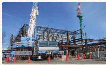
④ 体育館の鉄骨鉄筋コンクリート工事 (令和2年2月)
