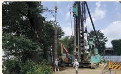
① 杭工事 (令和元年8月)
