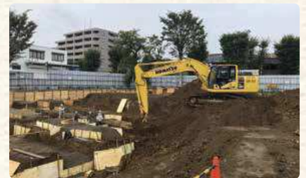
② 土工事 (令和元年9月)
