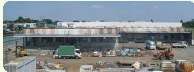
新学校給食共同調理場の建設工事の様子
