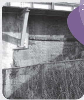
旧多摩川避溢橋日野方橋台
