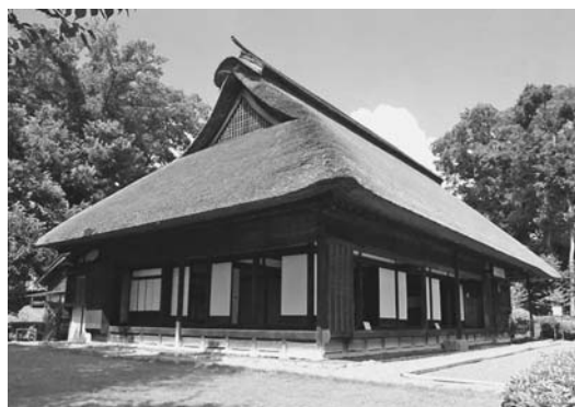
川越道緑地古民家園内「小林家住宅」
