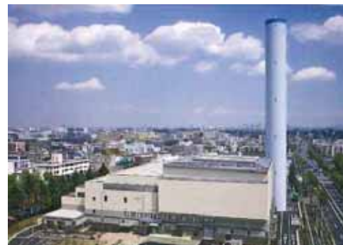
図5 他事例の煙突高さ及び航空障害灯／昼間障害標識の設置状況
