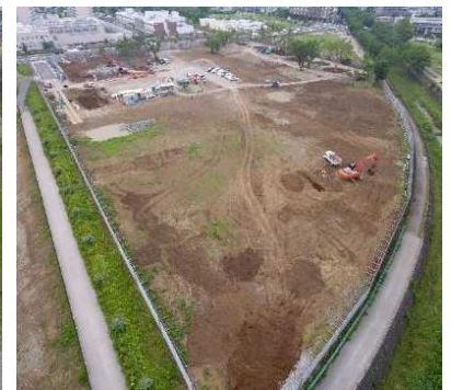
撤去状況 R2・6月
