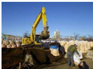
汚染土壌撤去袋詰め状況
