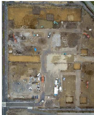
汚染土壌搬出完了 R2・2月
