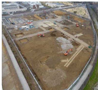
撤去状況 R2・2月
