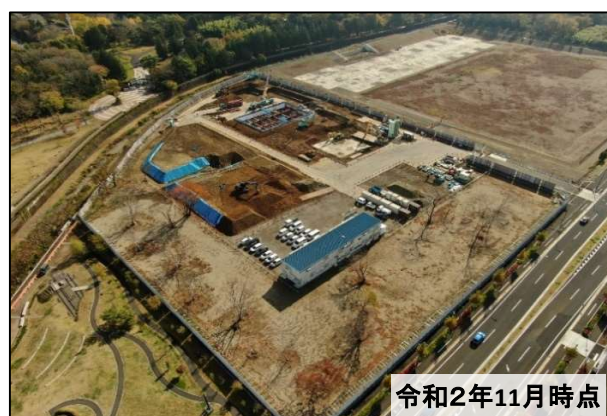
全景写真(敷地北西より)
