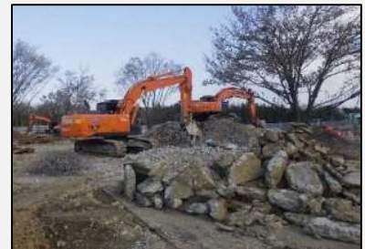
既存構造物の撤去
