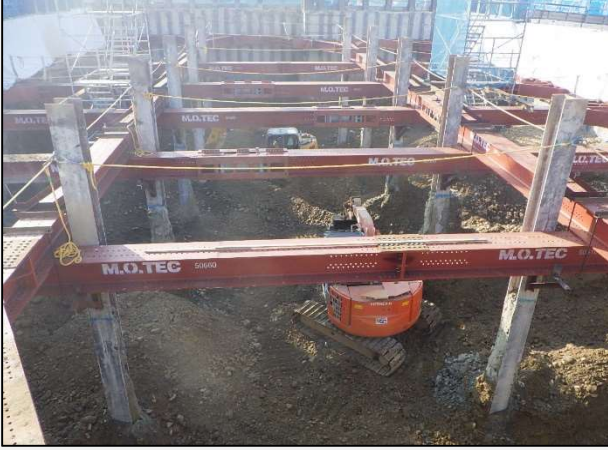
掘削工事状況
