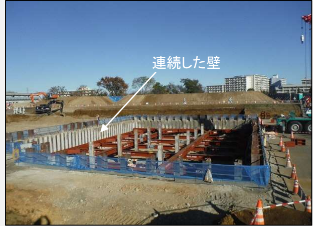
切梁工事状況
