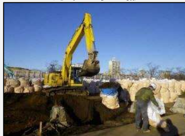
汚染土壌の撤去
