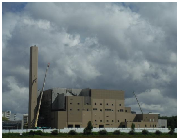
南側 全景(工場棟外壁仕上げ工事)
