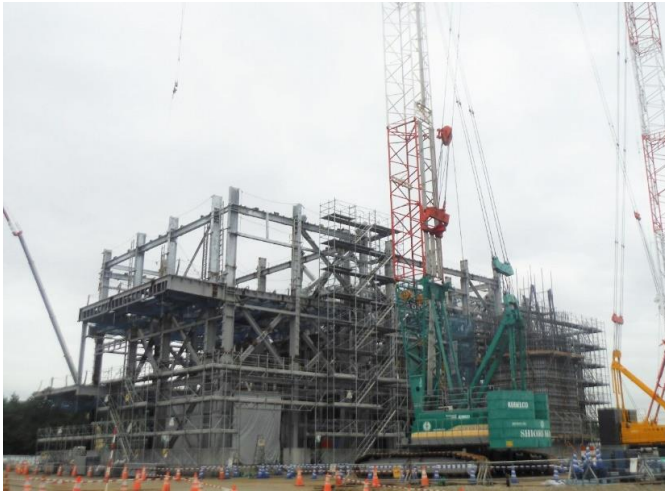
工場棟の鉄骨工事などが進んでいます。
