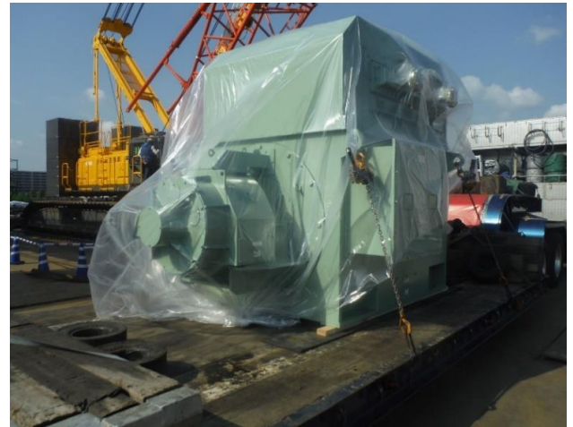
蒸気タービン発電機が搬入されました。
