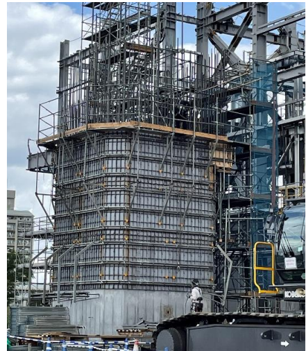
煙突外筒の工事が進んでいます。
