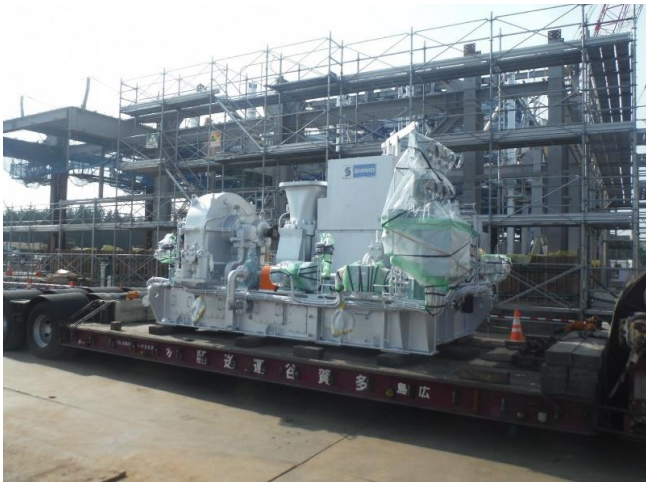
蒸気タービンが搬入されました。
