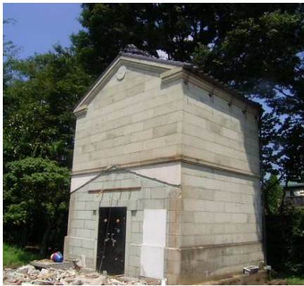
解体前の石積の外観
