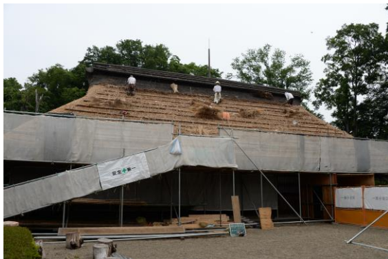
工事中の古民家園
