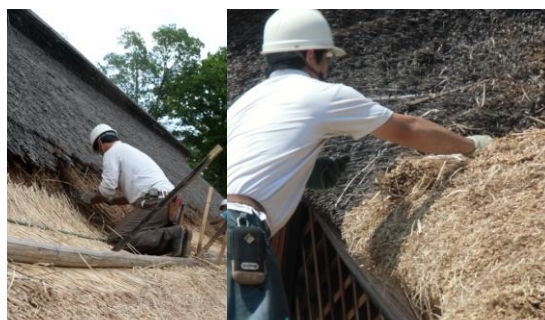
① 古茅抜き ② 新茅の差し入れ
