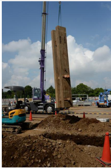
6. 挟み木の設置。
