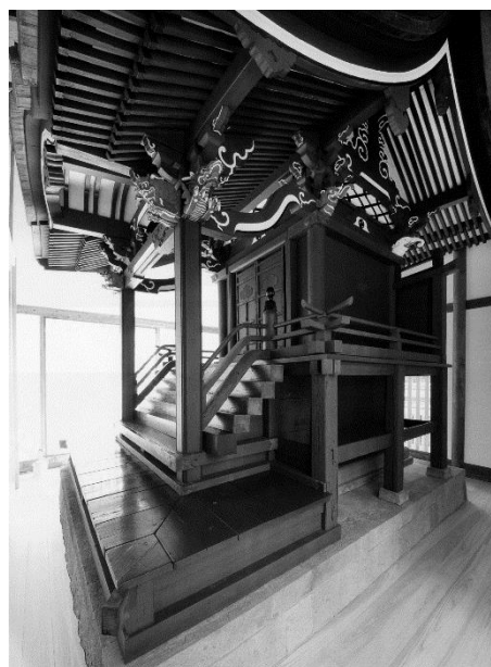
竣工した本殿
