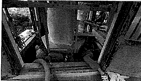
令和3年解体作業 内部・地中 コンクリート解体し、板石を 取外す。微振動工具の手作業
