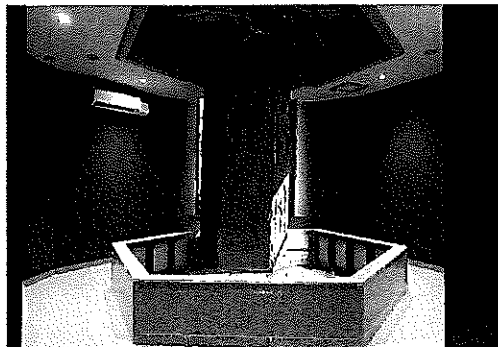
国宝新保存庫内 施工状況
