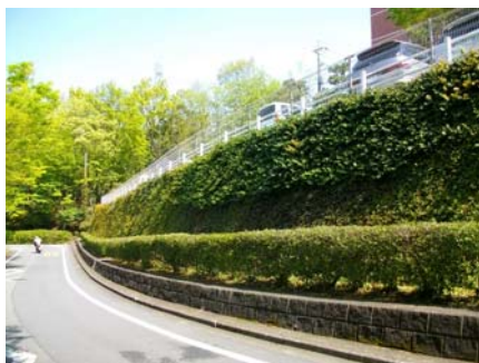
緑化擁壁の活用
