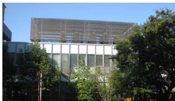
ルーバーによる屋上設備類の遮蔽
