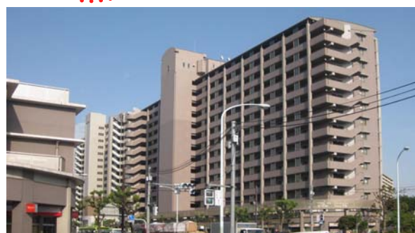
屋外階段と建築物本体との調和
