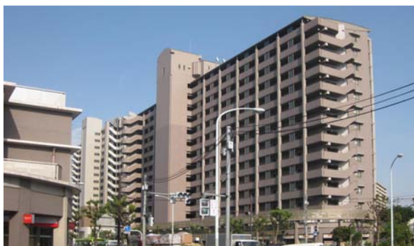
屋外階段と建築物本体との調和
