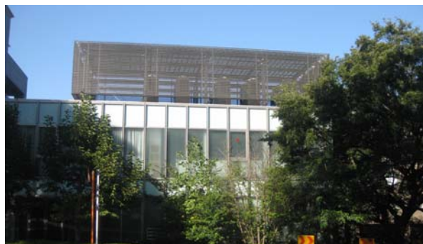
ルーバーによる屋上設備類の遮蔽
