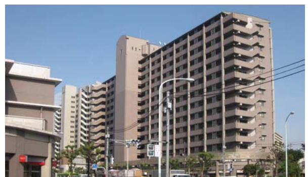
屋外階段と建築物本体との調和
