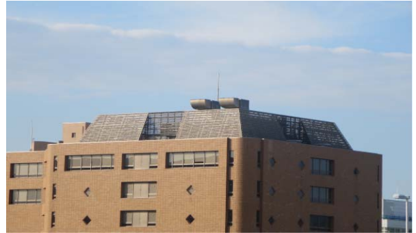
ルーバーによる屋上設備類の遮蔽
