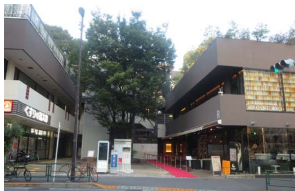
オープンスペースに設けられたシンボルツリー
