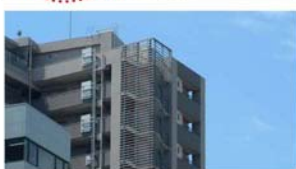
ルーバーにより屋外階段を修景
