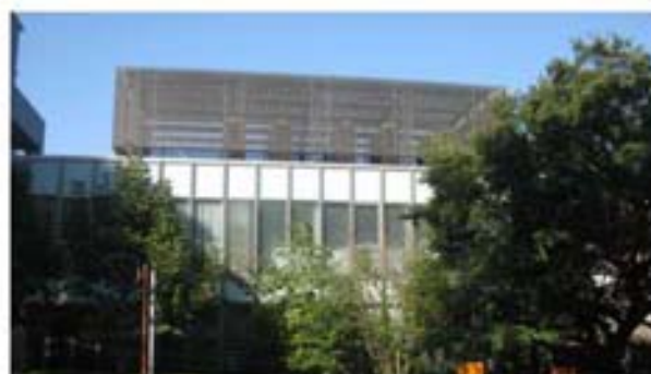
ルーバーによる屋上設備類の遮蔽
