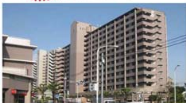
屋外階段と建築物本体との調和
