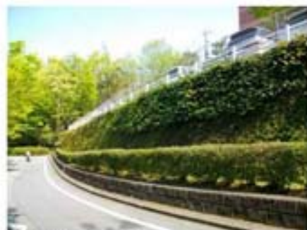
緑化擁壁の活用
