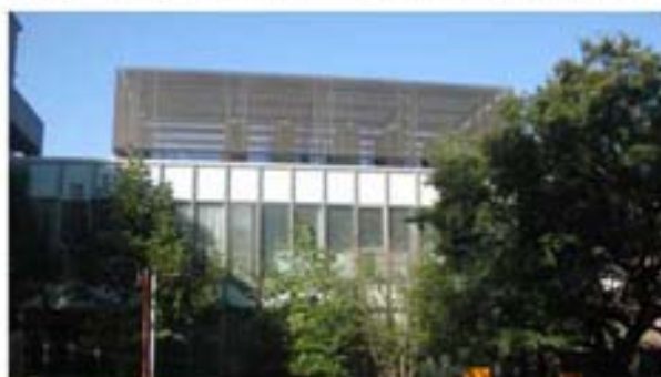
ルーバーによる屋上設備類の遮蔽
