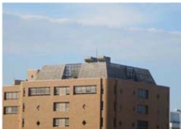
ルーバーによる屋上設備類の遮蔽
