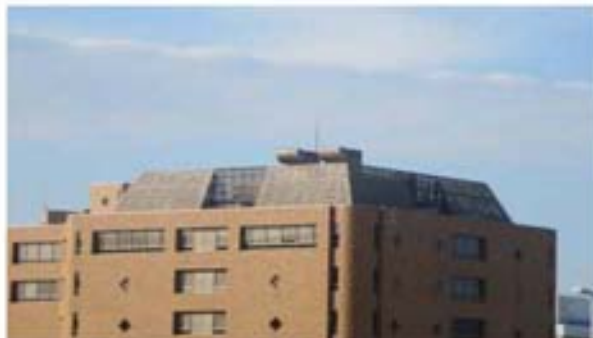
ルーバーによる屋上設備類の遮蔽
