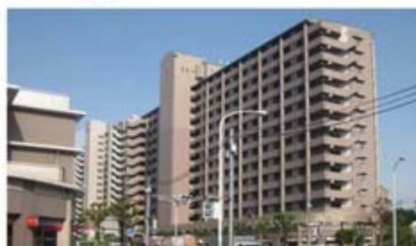
屋外階段と建築物本体との調和
