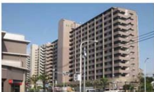
屋外階段と建築物本体との調和
