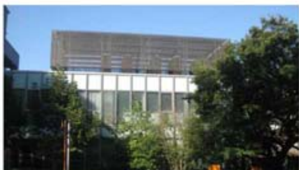
ルーバーによる屋上設備類の遮蔽
