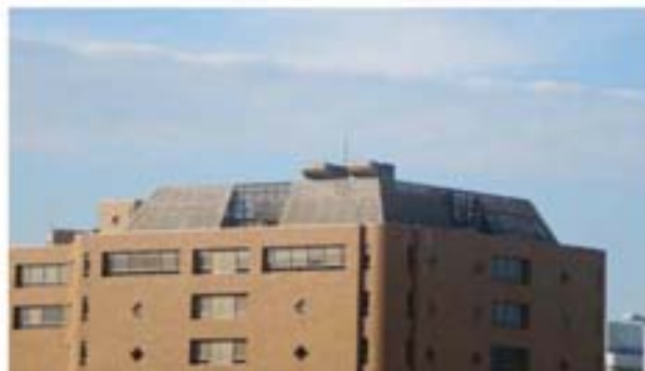
ルーバーによる屋上設備類の遮蔽
