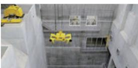
ごみは一旦ごみピットに貯留し、ごみクレーンで攪拌を行い均質化した後、ごみ投入ホッパから焼却炉へ送られます。
