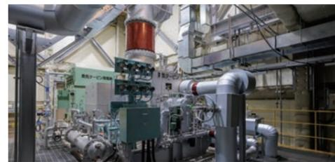
ボイラーでつくった蒸気を利用して、蒸気タービンを回し、最大2,390kWの電力を発生させます。つくられた電気は施設内の電力を賄うとともに余剰電力は売電します。
