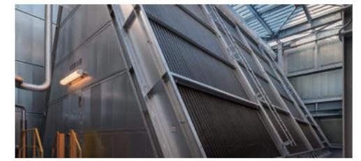
蒸気タービンの排気を冷却、凝縮させ、再びボイラー用水として再利用します。
