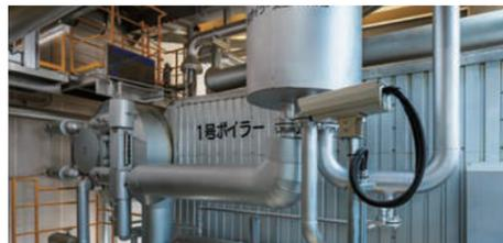
焼却炉より送られてきた排ガスの熱を利用して蒸気をつくります。この蒸気により、電気やお湯が作られます。
