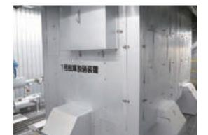
排ガス中に微量に残っているダイオキシン類や窒素酸化物を触媒の働きにより分解します。
